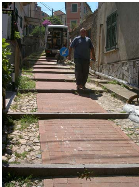
vista del borgo marinaro di Lerici colta dal cantiere di Pugliola e scorcio della via Casini oggetto dell'intervento, con la struttura della pavimentazione in mattonato-acciottolato tipico delle "creuze de ma"
