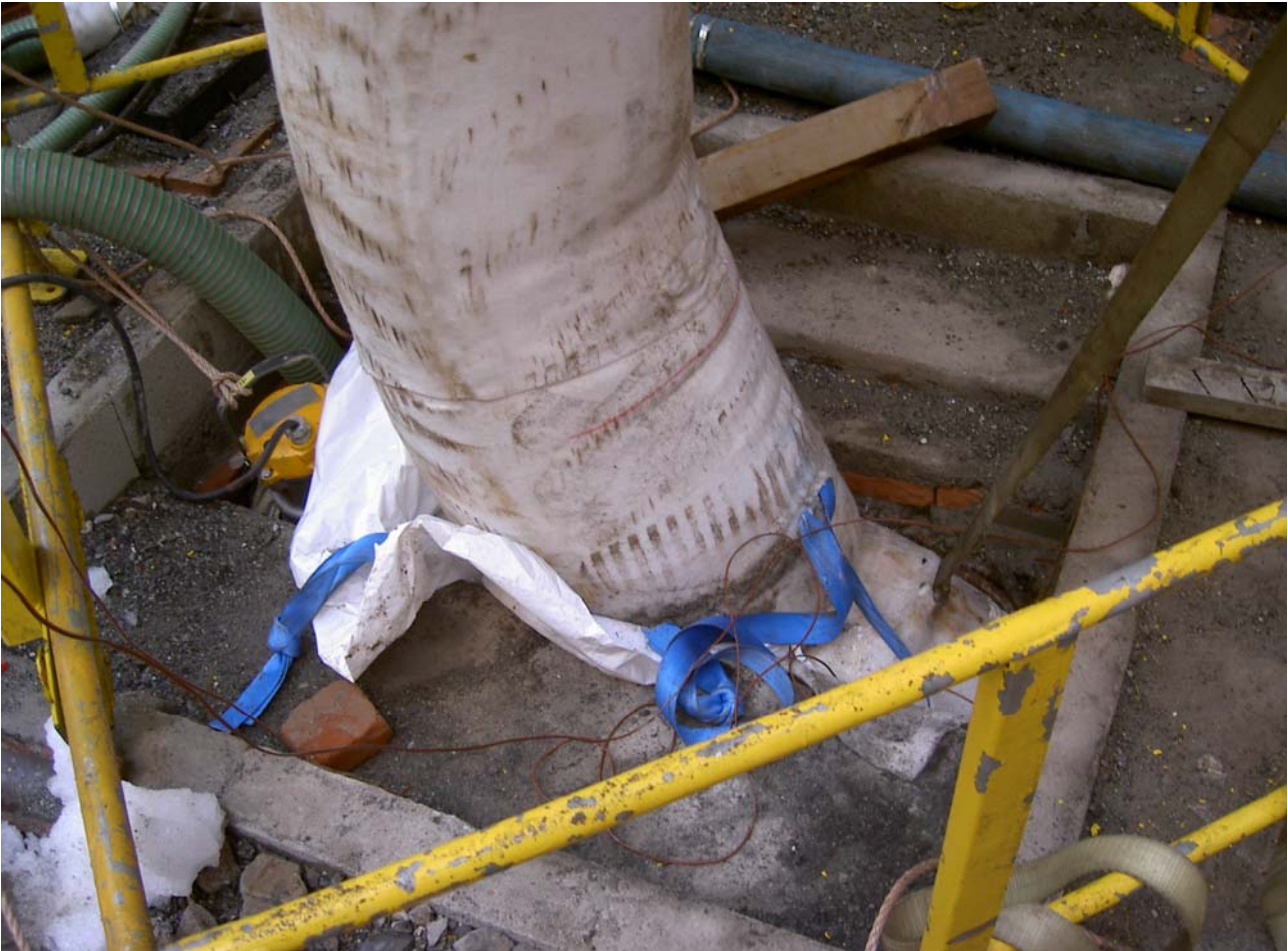
Fase dell'inserzione della guaina nel pozzetto sulla verticale del collettore
