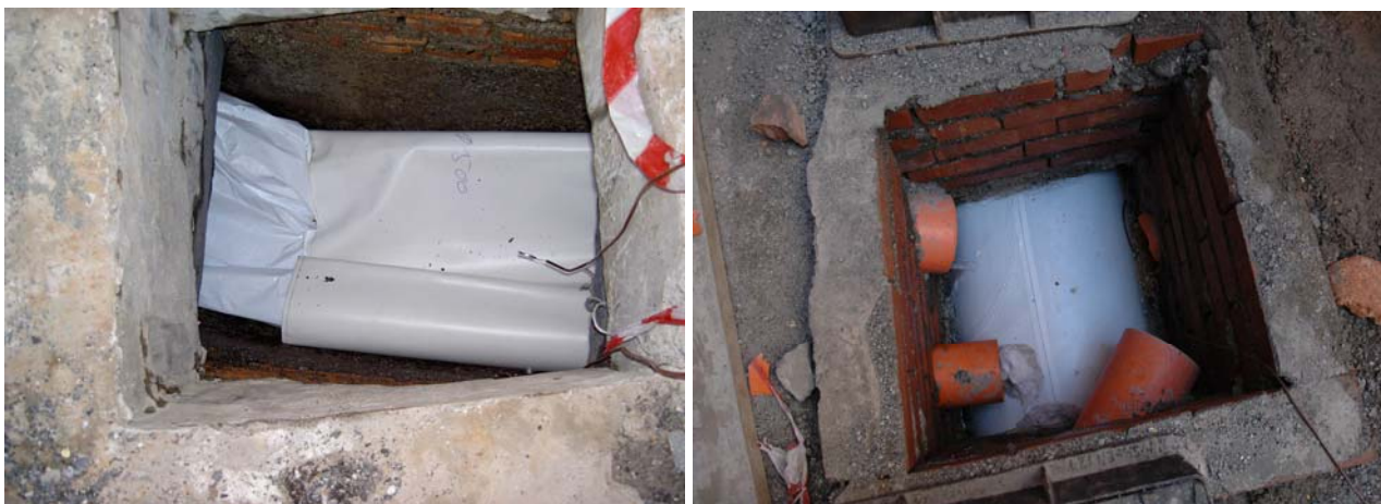
Immagini del preliner di rinforzo e della guaina in fase di termoindurimento colte attraverso i pozzetti di ispezione
