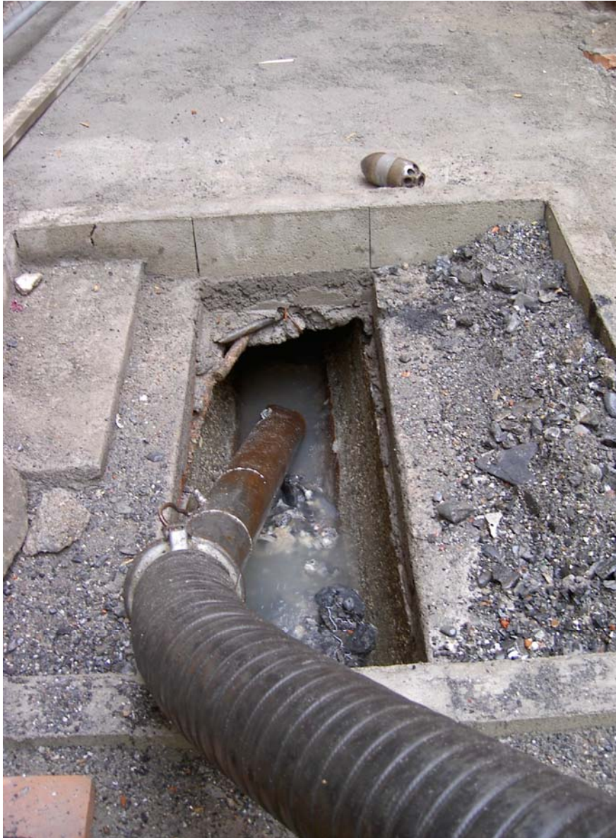
La condizione interna originale del collettore visibile attraverso il punto di avvio del risanamento
