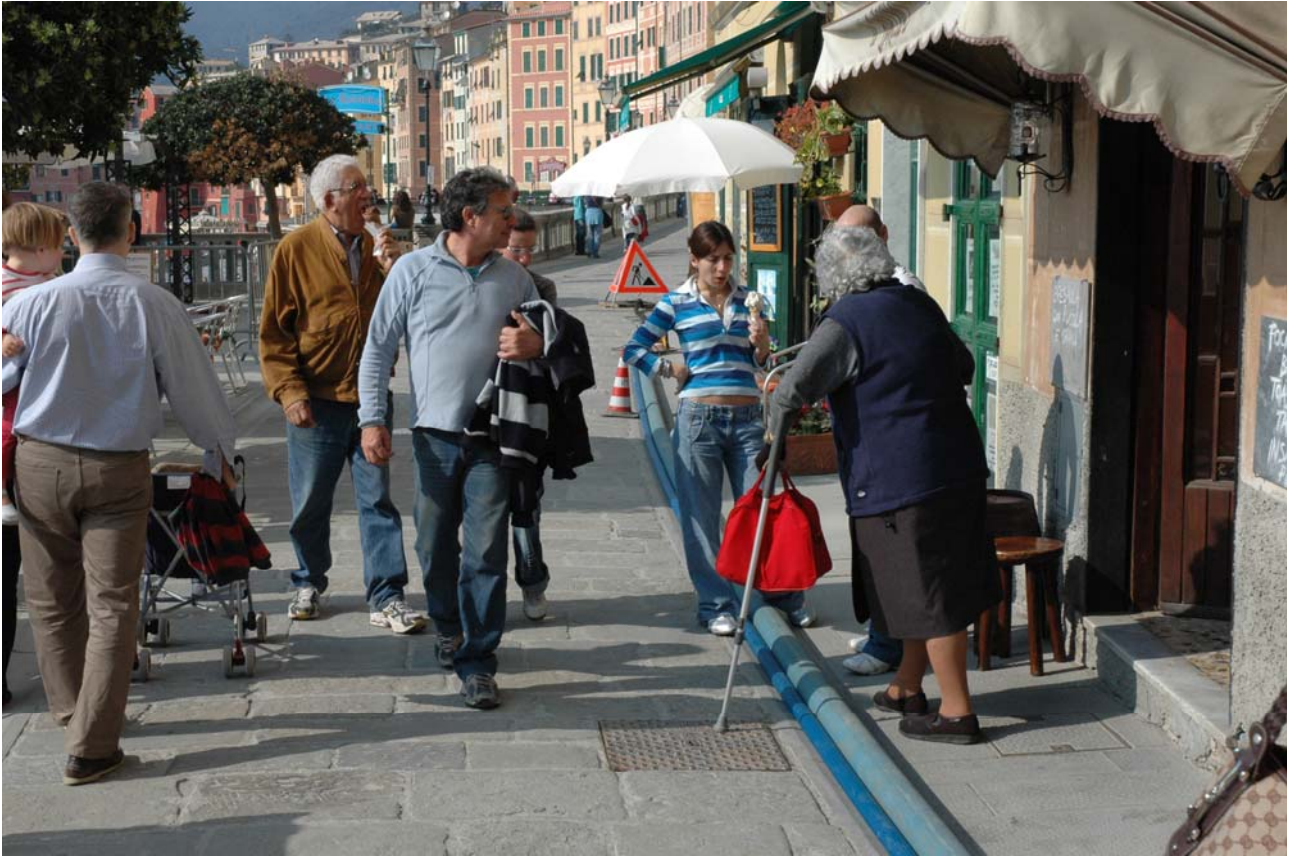
Immagine delle tubazioni flessibili di by-pass già in esercizio
