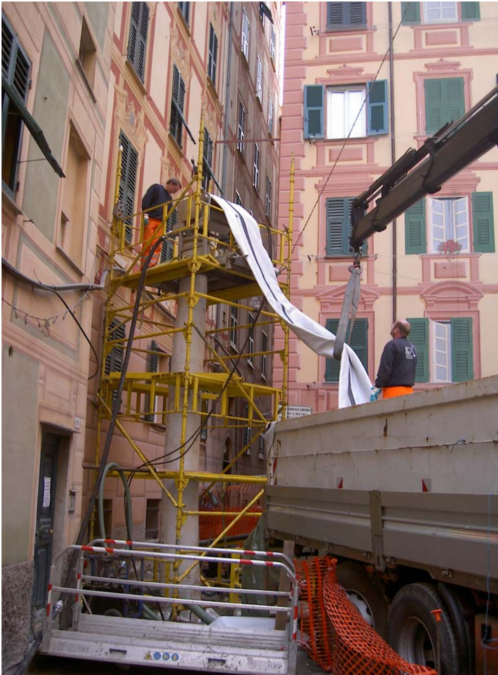
Particolare dell'installazione del castello di inversione
