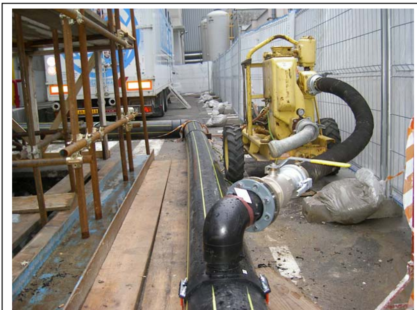
immissione secondaria di grandi dimensioni dotata di valvola di non ritorno
