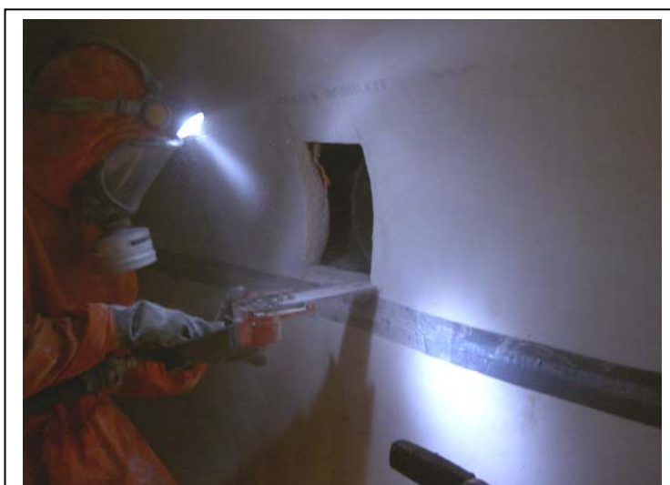
riapertura manuale di un innesto laterale
