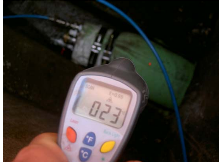
misurazione della temperatura della guaina in fase di termindurimento con termometro laser
