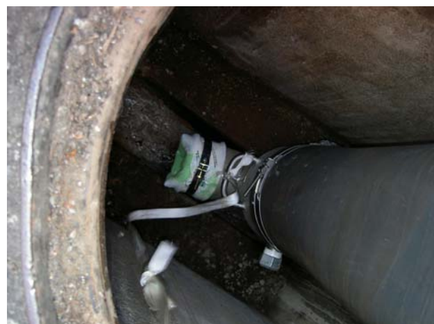
fasi di predisposizione delle attrezzature e di avvio di processo di inversione in ambient curing
