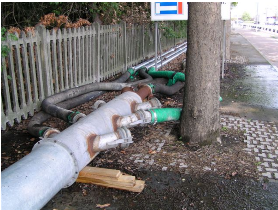
colonna di collettamento di manichette provenienti da fognoli bypassati conferenti in un'unica condotta di by-pass
