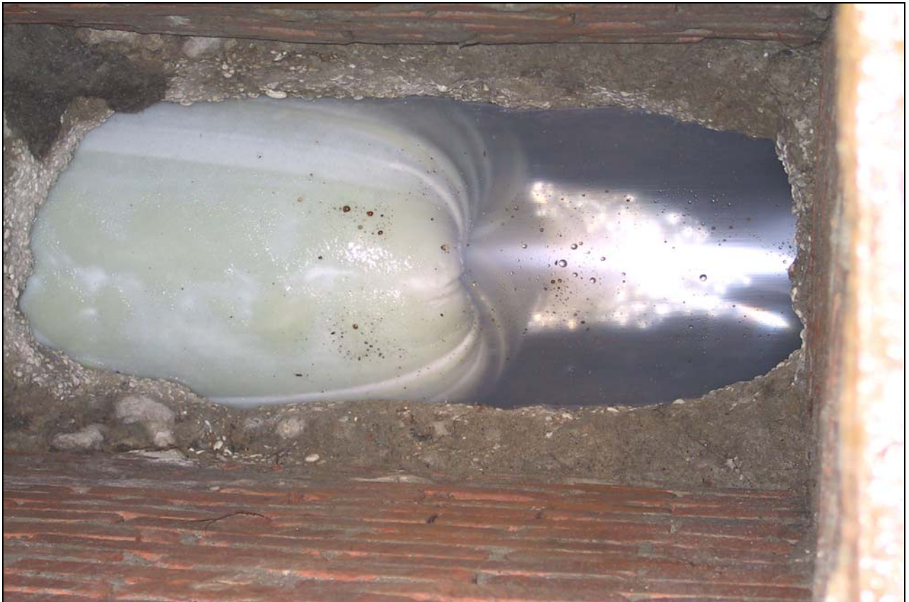
fronte di avanzamento di una guaina CIPP in fase di inversione
