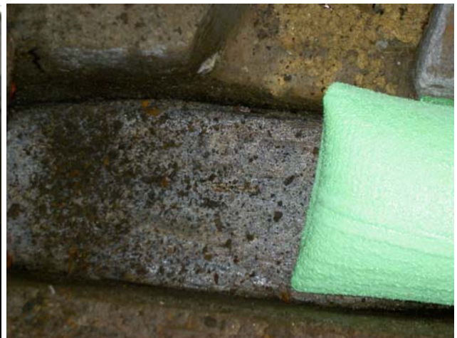
tubolare in feltro in parte impregnato ed in parte tal quale e guaina impregnata in fase di estroflessione ad aria (ambient curing)
