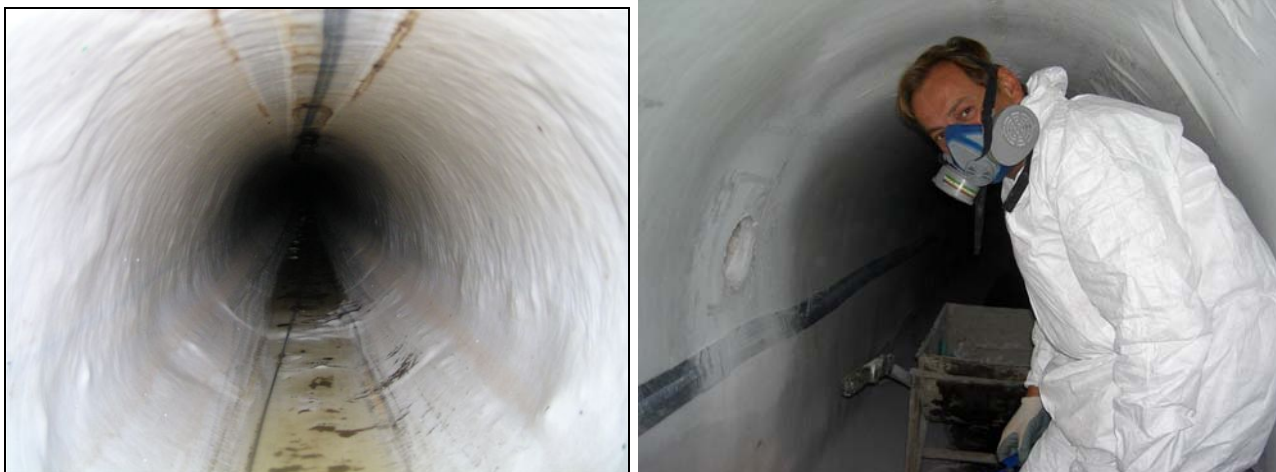
esiti di risanamento di una condotta circolare e di un manufatto a profilo rettangolare con soletta a volta
