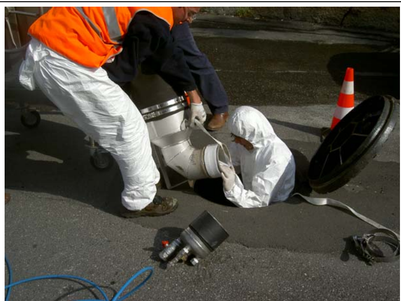
ambient curing di fognature civili di modeste dimensioni effettuato direttamente da pozzetto di ispezione
