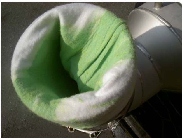
tubolare in feltro in parte impregnato ed in parte tal quale e guaina impregnata in fase di estroflessione ad aria (ambient curing)
