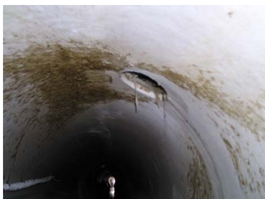
particolare della rifinitura a stucco chimico di un terminale e di una riapertura dall'interno di una immissione laterale
