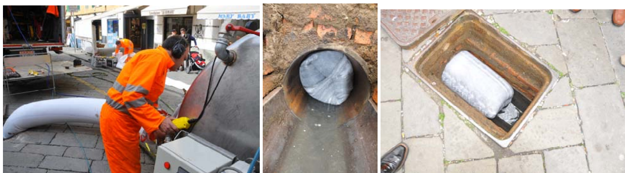
Tre fasi del procedimento di estroflessione della calza in feltro impregnato e dell'avanzamento della stessa all'interno della condotta fognaria DN350
