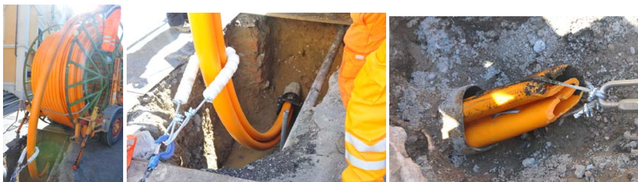
Tre fasi dell'inserimento del tubo gas C-Compact all'interno della condotta in ghisa grigia DN200
