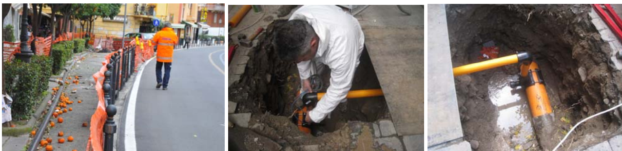
Una veduta dell'impianto di by-pass e delle fasi di ricostruzione delle prese sulla nuova condotta C-Compact riformata all'interno della vecchia in ghisa grigia
