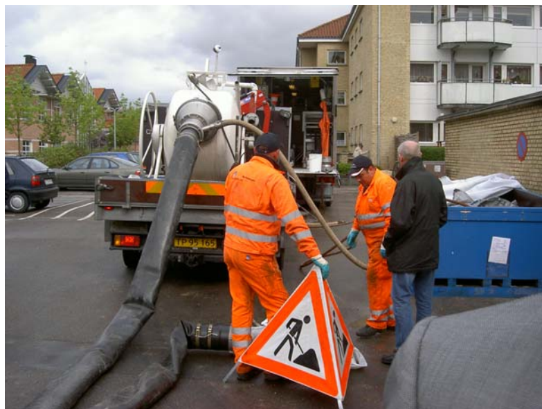
Fase di avvio di un cantiere di relining con tecnologia Cured in Place Pipe
