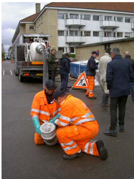
Fase di avvio di un cantiere di relining con tecnologia Cured in Place Pipe
