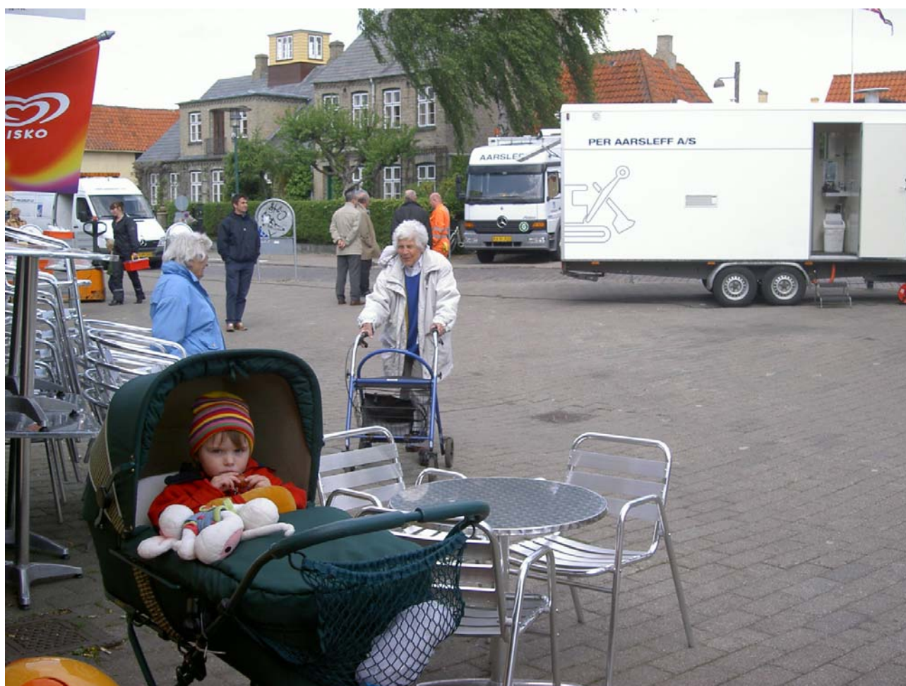
La vita in superficie continua indisturbata, e la popolazione danese è abituata ad assistere al lavoro dei risanatori di fognature
