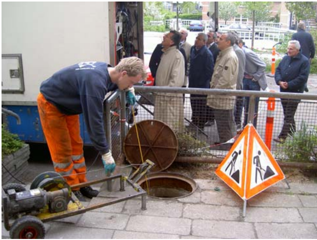
Fasi dell'ispezione televisiva programmata che viene effettuata periodicamente su tutta la rete fognaria danese
