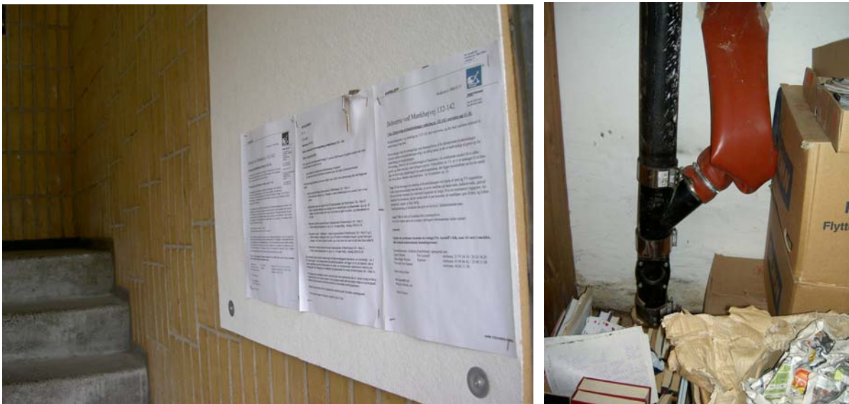
Gli avvisi all’utenza completi della spiegazione dettagliata di quello che si andrà ad eseguire, e un particolare di un intervento eseguito all’interno degli edifici per risanare un fognolo privato
