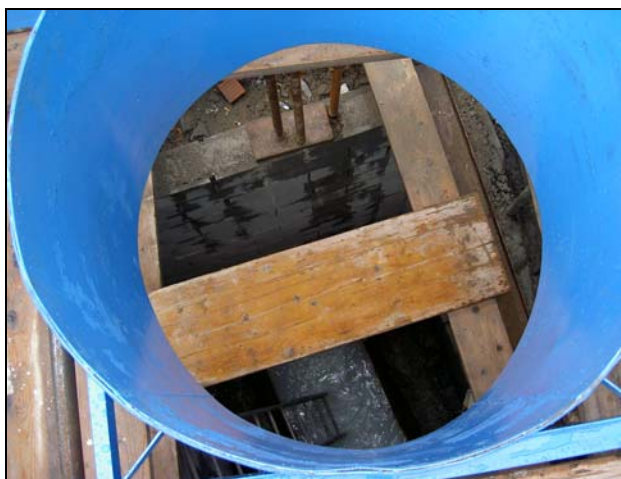
fasi di costruzione del castello di inserzione e particolare della flangia di inversione
