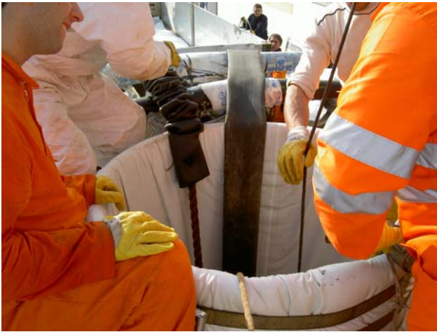
preparazione della fase di ricircolo dell'acqua calda
