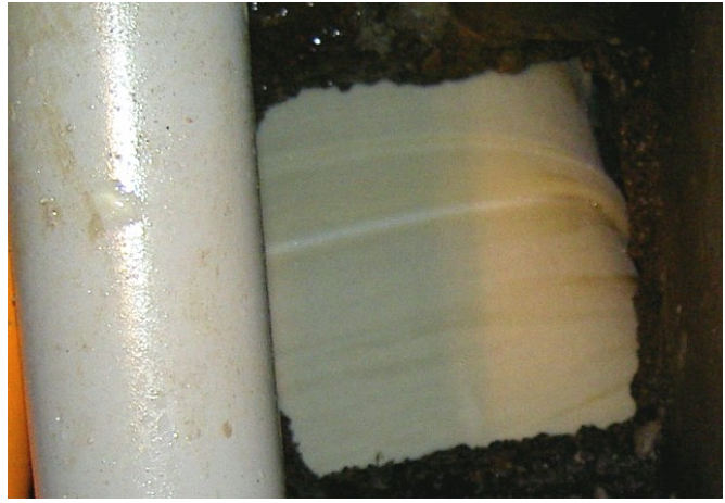
avanzamento della guaina vista attraverso un pozzetto
