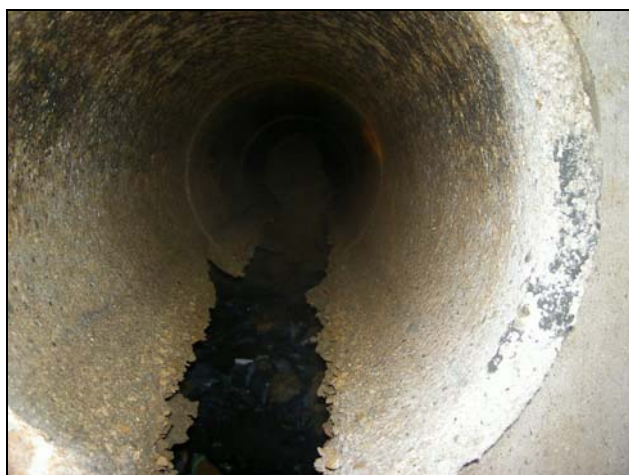
lo scorrere dei reflui attraverso un fognolo DN400 con il fondo completamente eroso, ha provocato un pericoloso aggrottamento del terreno circostante per un volume di ca 25 metri cubi.
