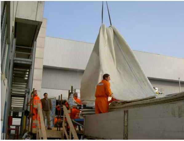
fasi di inserzione e rovesciamento della guaina
