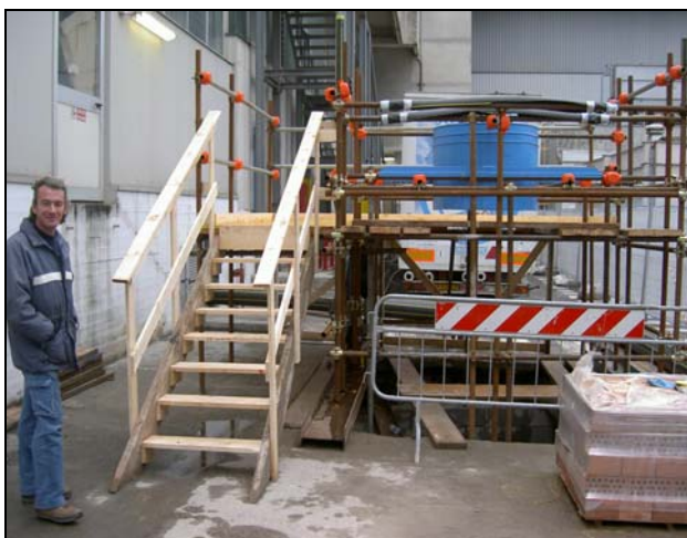
fasi di costruzione del castello di inserzione e particolare della flangia di inversione
