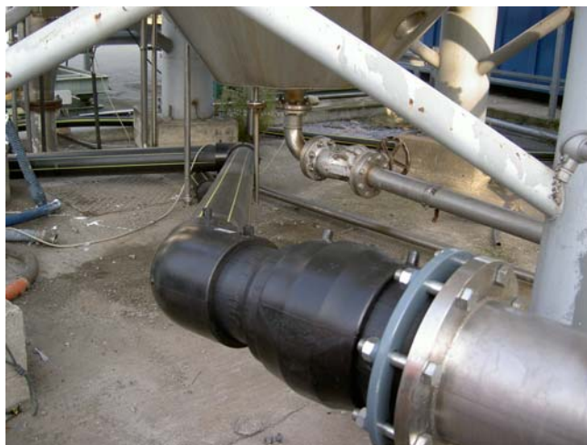
By-pass secondario. Punto di aspirazione presidiato nei fondi dello stabilimento e collegamento ad impianto
