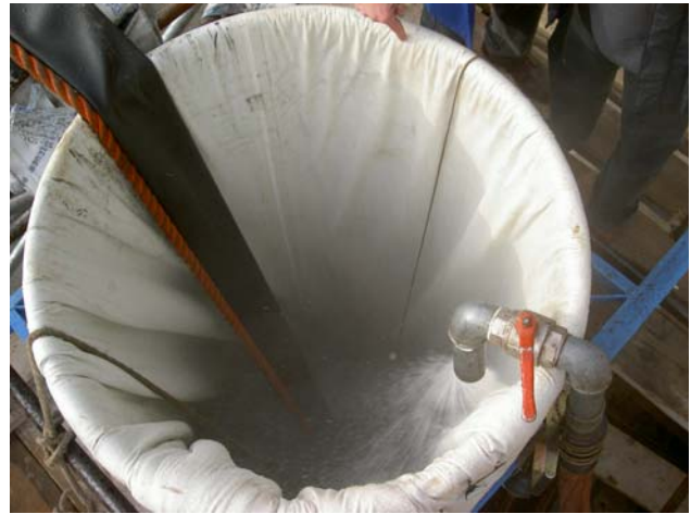
avvio della fase di consolidamento in temperatura
