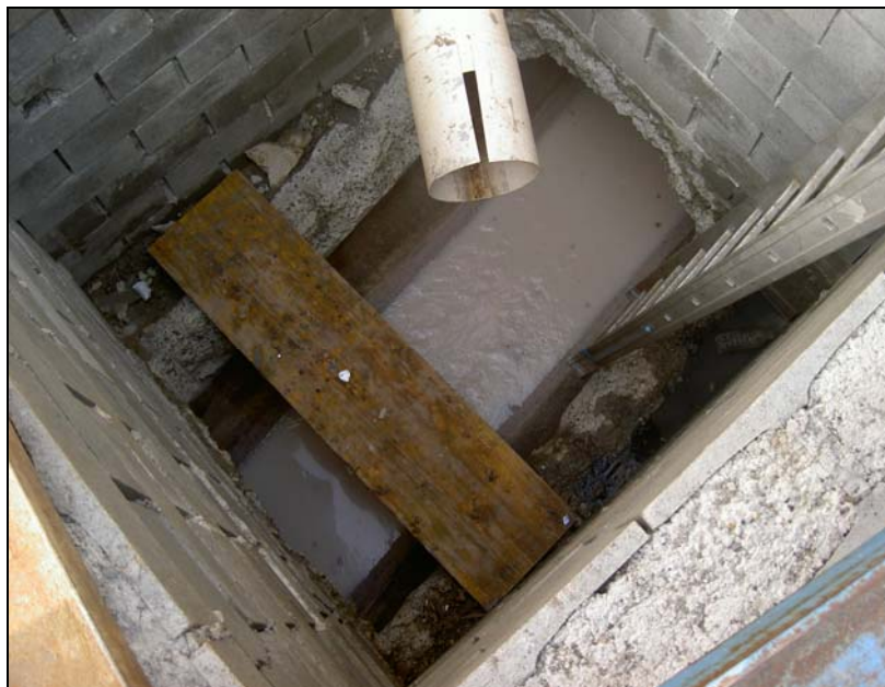
costruzione del pozzo di inserzione principale
