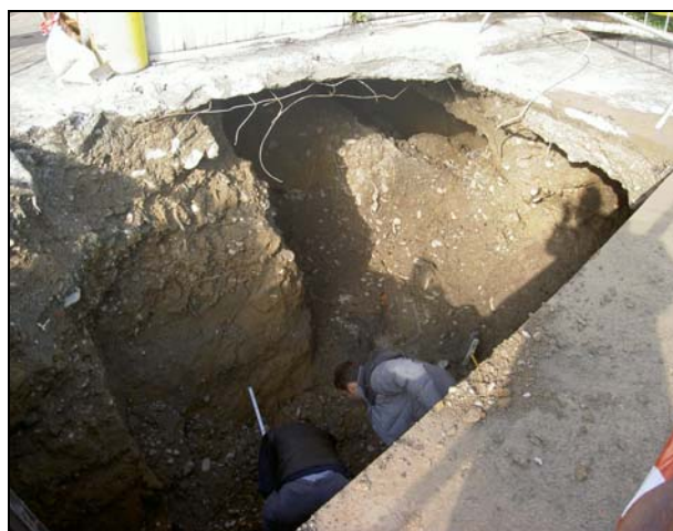
lo scorrere dei reflui attraverso un fognolo DN400 con il fondo completamente eroso, ha provocato un pericoloso aggrottamento del terreno circostante per un volume di ca 25 metri cubi.
