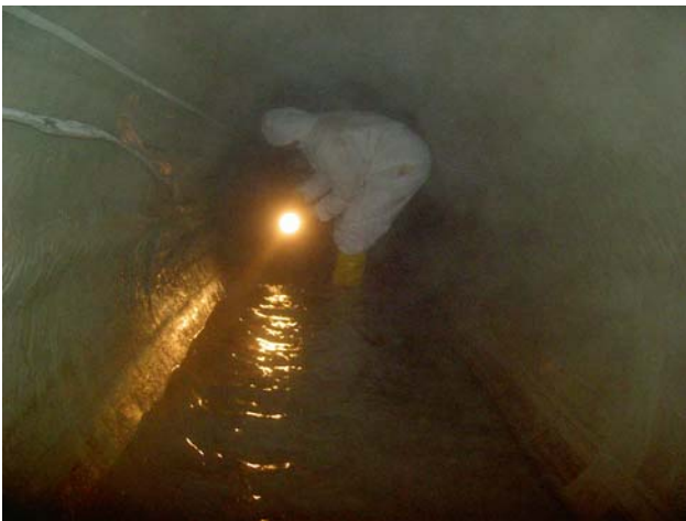
fase di controllo di consolidamento a processo terminato
