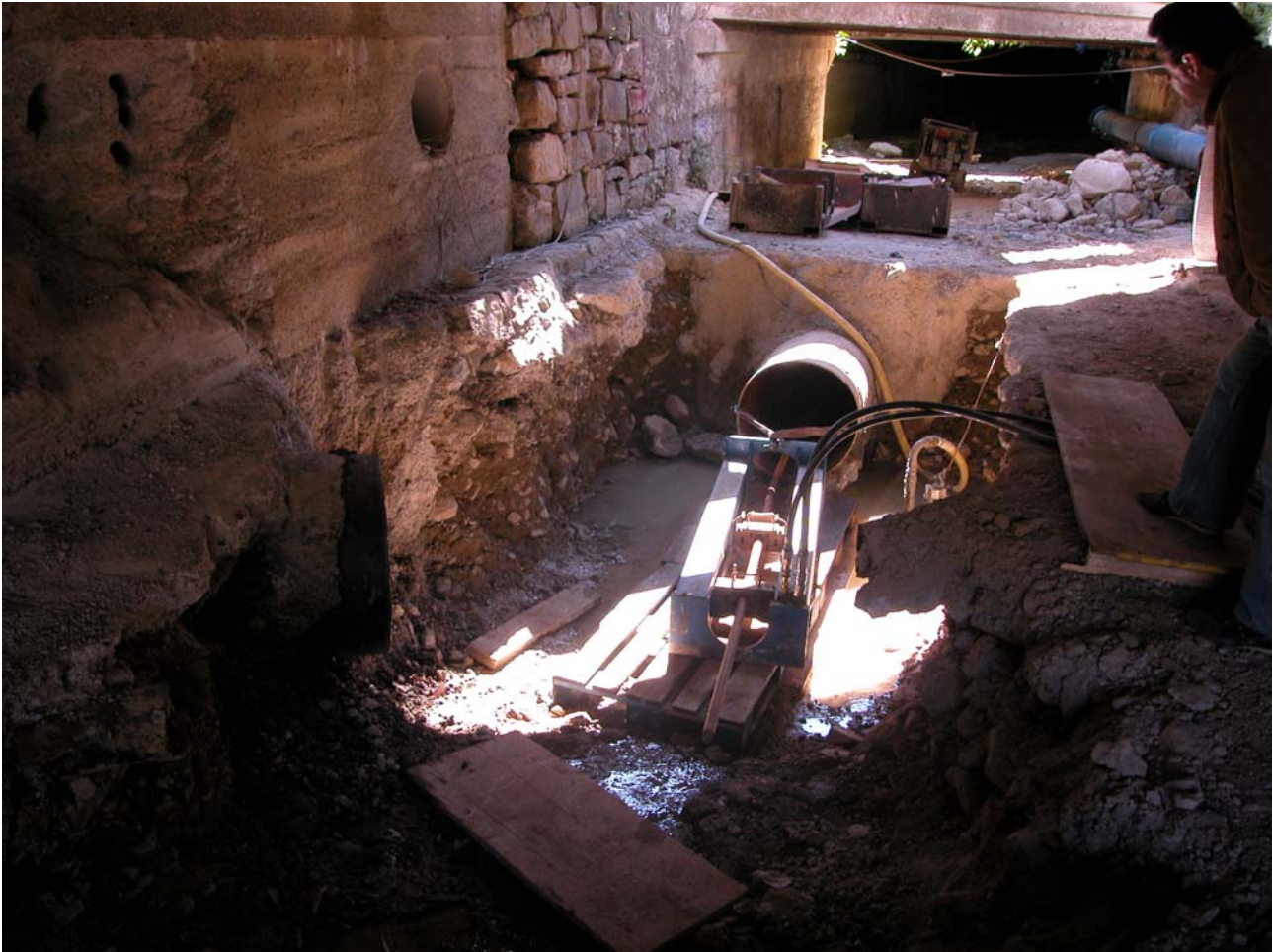
La sacrificata posizione di lavoro facente le funzioni di scavo di traino, con già posizionata la macchina tiraste idraulica da 40 tons
