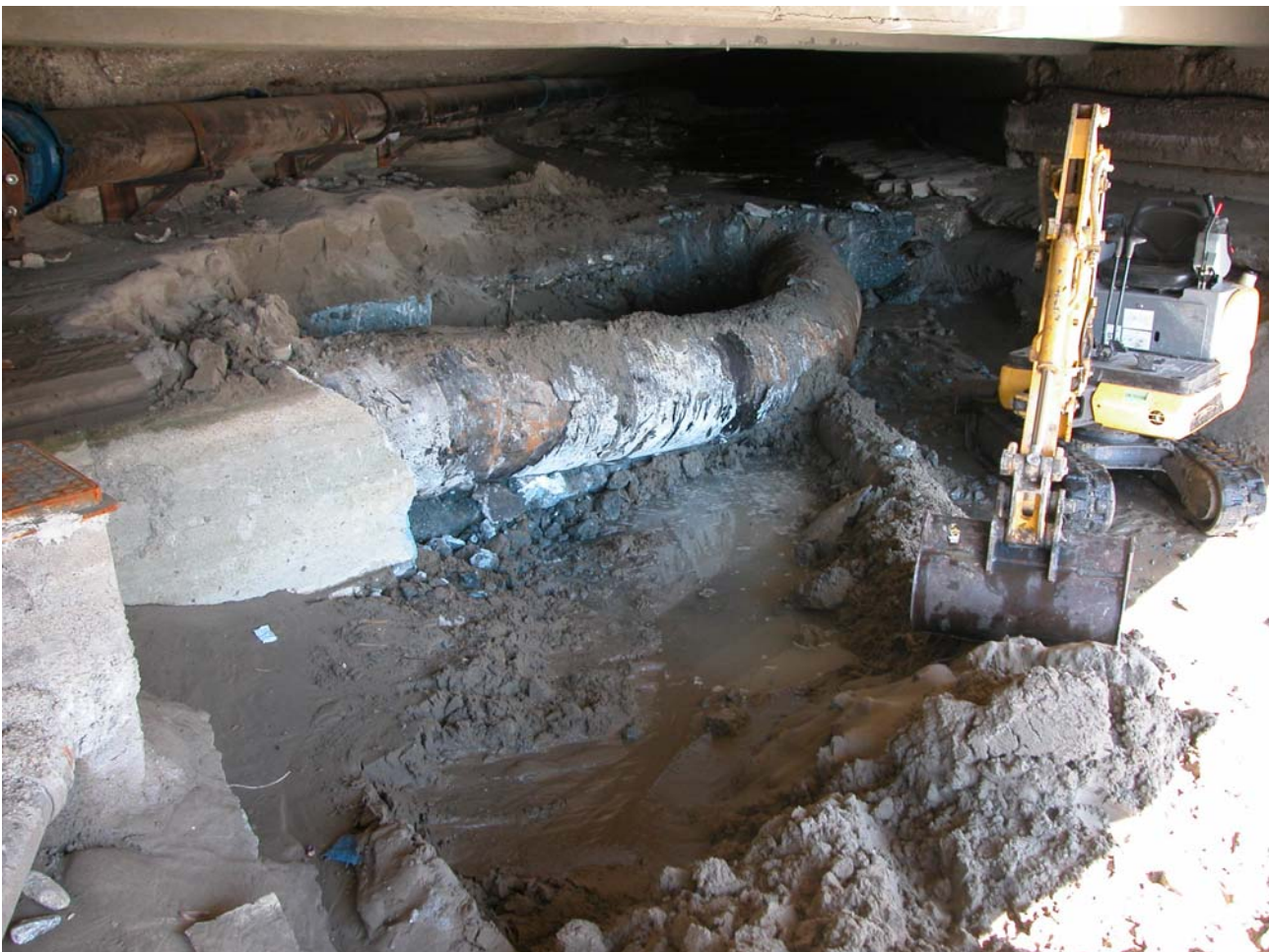
Lo stato di fatto della condotta DE700 portata a giorno in corrispondenza dello sbocco del rio Murtola a Diano Marina
