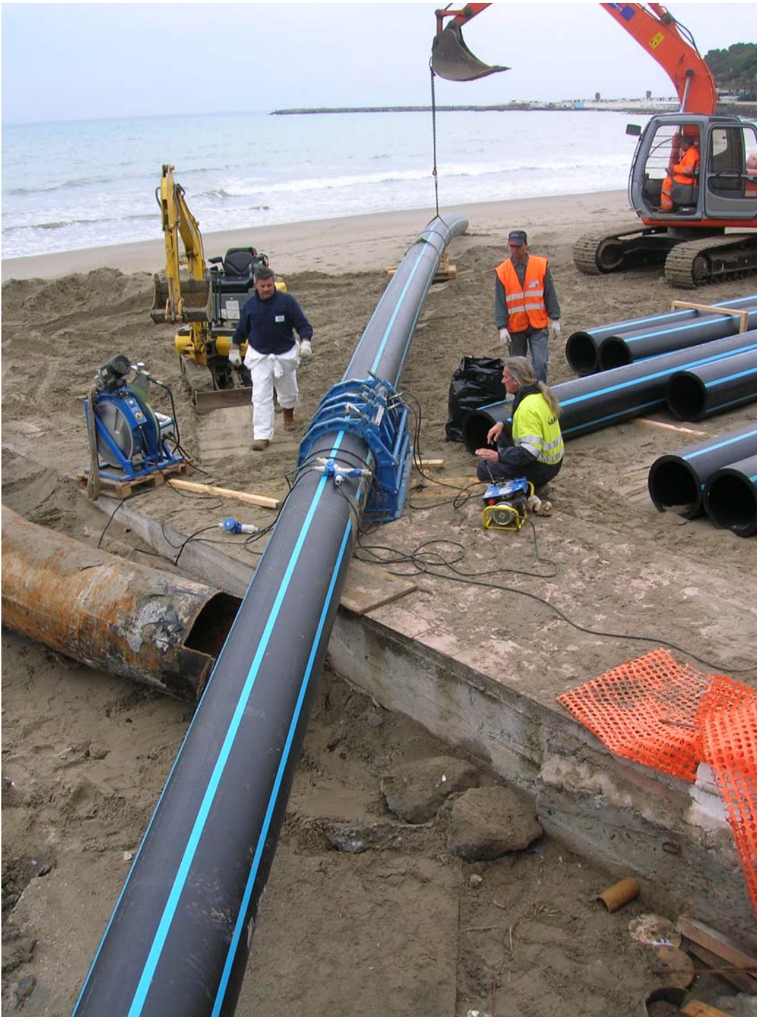
Veduta della zona di cantiere sulla spiaggia di Diano Marina
