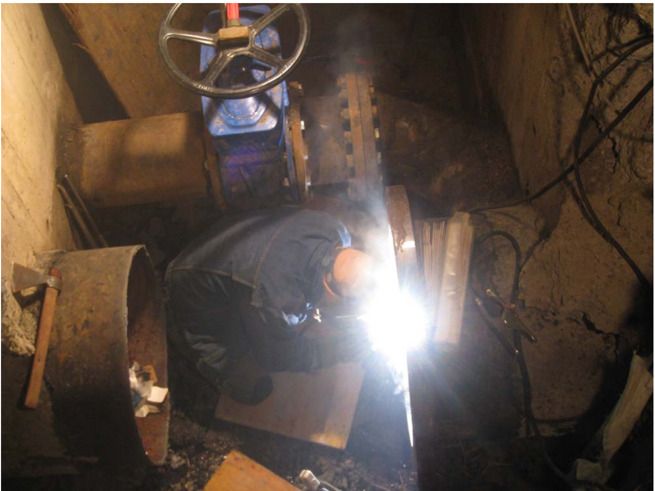
Una fase delle laboriose operazioni di derivazione del by-pass dalla condotta principale
