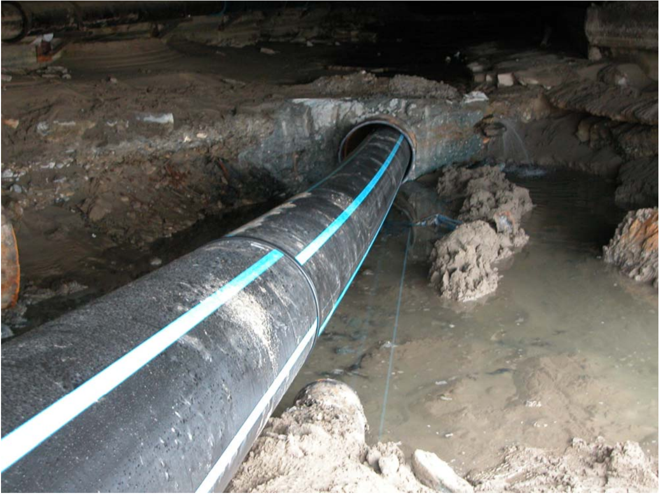
Una delle prime fasi di inserzione del liner
