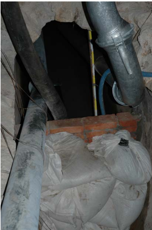
Particolare del setto di separazione delle acque potabili dalla zona di lavoro
