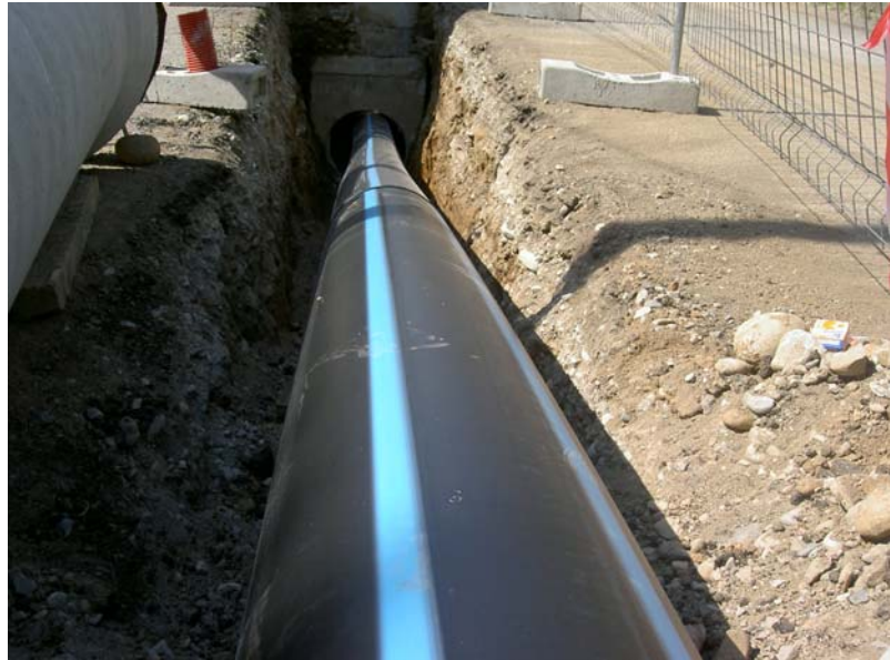
foto 2, 3, 4 fasi dell'inserzione del tubo in pead
