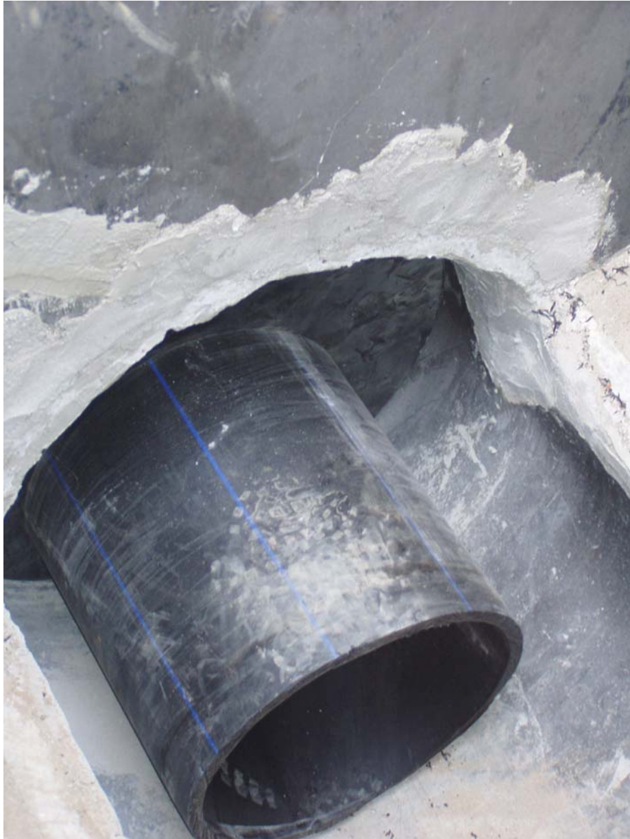
FOTO 6, PARTICOLARE DELLA SIGILLATURA DELLA CORONA CIRCOLARE TRA IL DN 800 E IL DN 500
