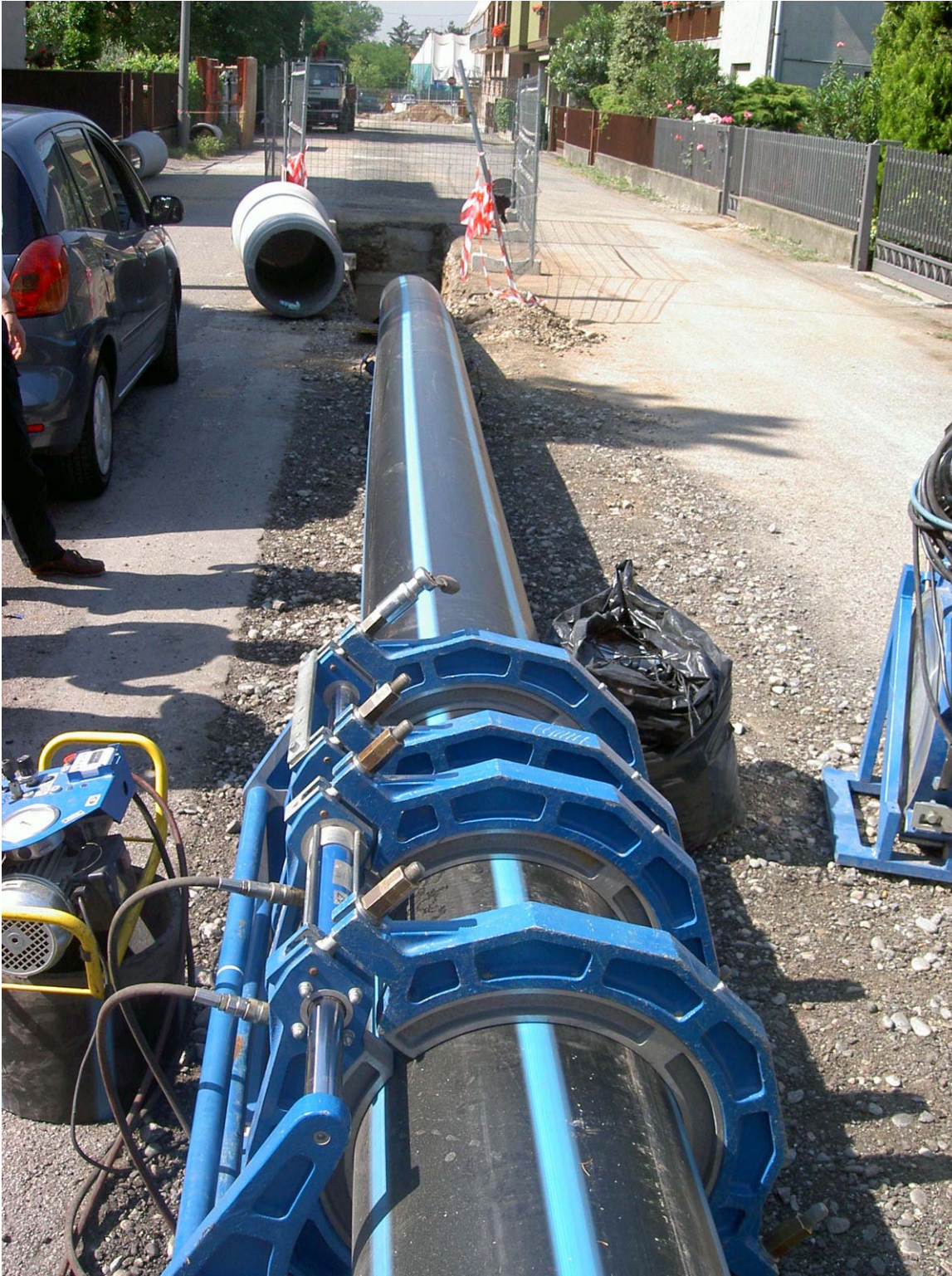
foto 1, fasi di saldatura tubo in pead
