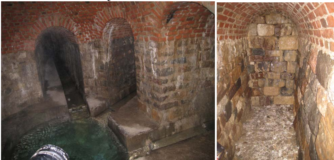
Veduta di una parte del complesso interrato dell'opera di presa dell'acquedotto Fisterre
