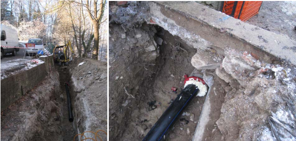
Due momenti della realizzazione dei lavori: la prima fossa di lancio, della quale si può apprezzare la profondità, e un particolare della sigillatura dell'intercapedine tra condotta esistente e liner in PEAD
