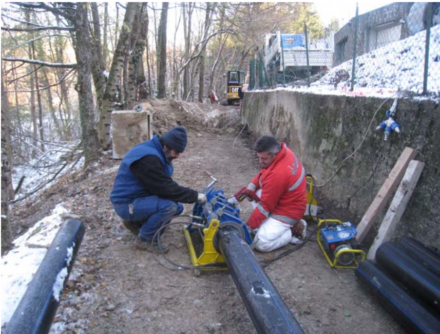
Una fase della saldatura dei tubi da inserire nella vecchia condotta
