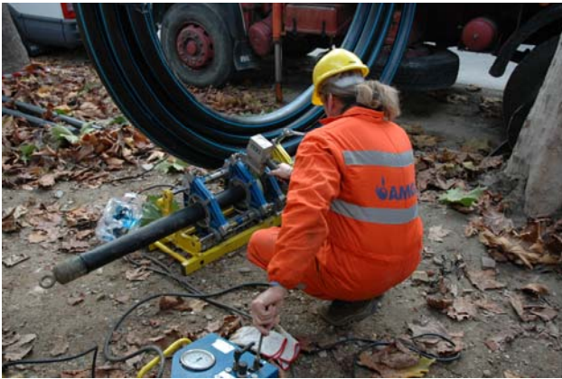
saldatura della testa di traino e collegamento del tubo in PEAD al cono alesatore ed al dispositivo di frantumazione
