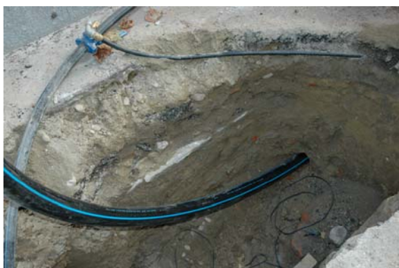
fasi di inserzione del tubo in PEAD e di sostituzione della vecchia condotta
